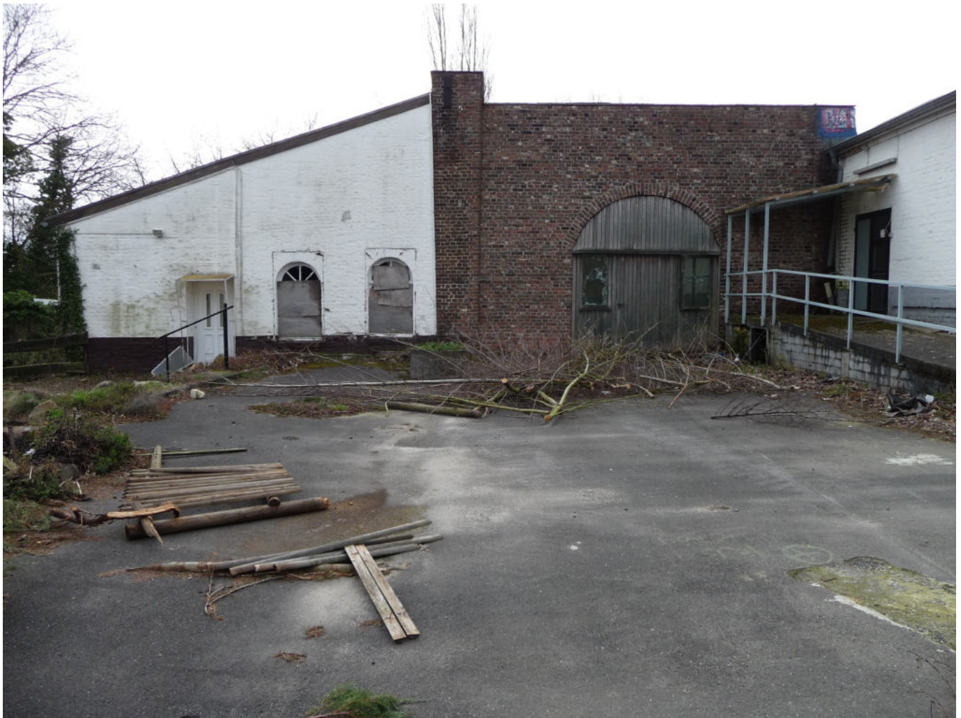
Nordansicht ehemaliges Schachtgebäude der Grube Langenberg mit Anbau
