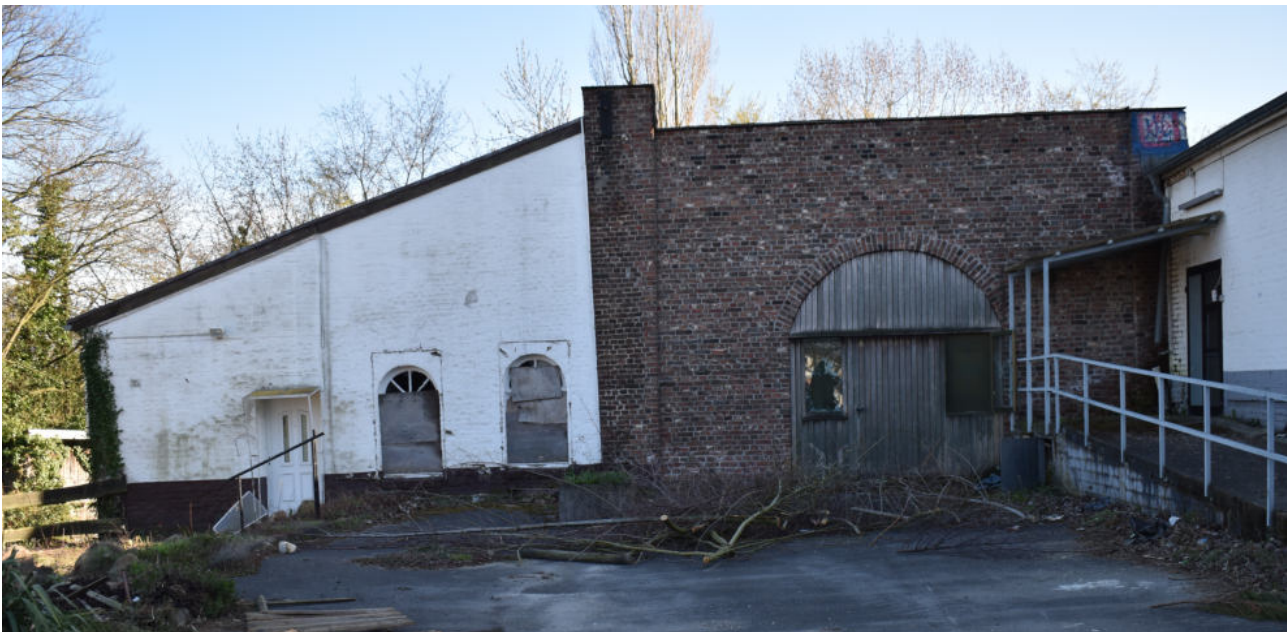
Abb. 8, Nordansicht des ehemaligen Schachtgebäudes mit Anbau, März 2019
