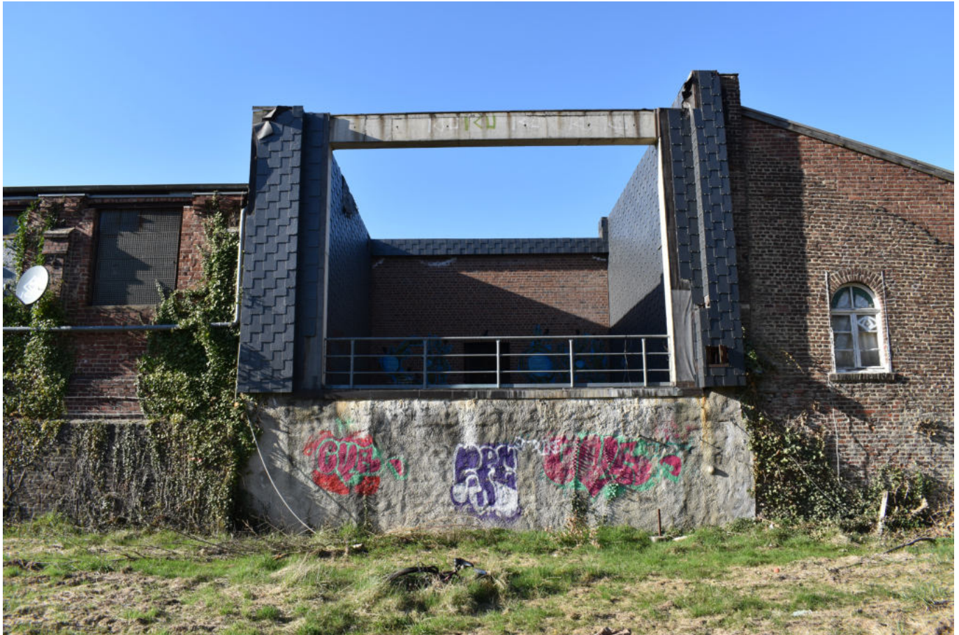
Südsansicht ehemaliges Schachtgebäude der Grube Langenberg mit Anbau
