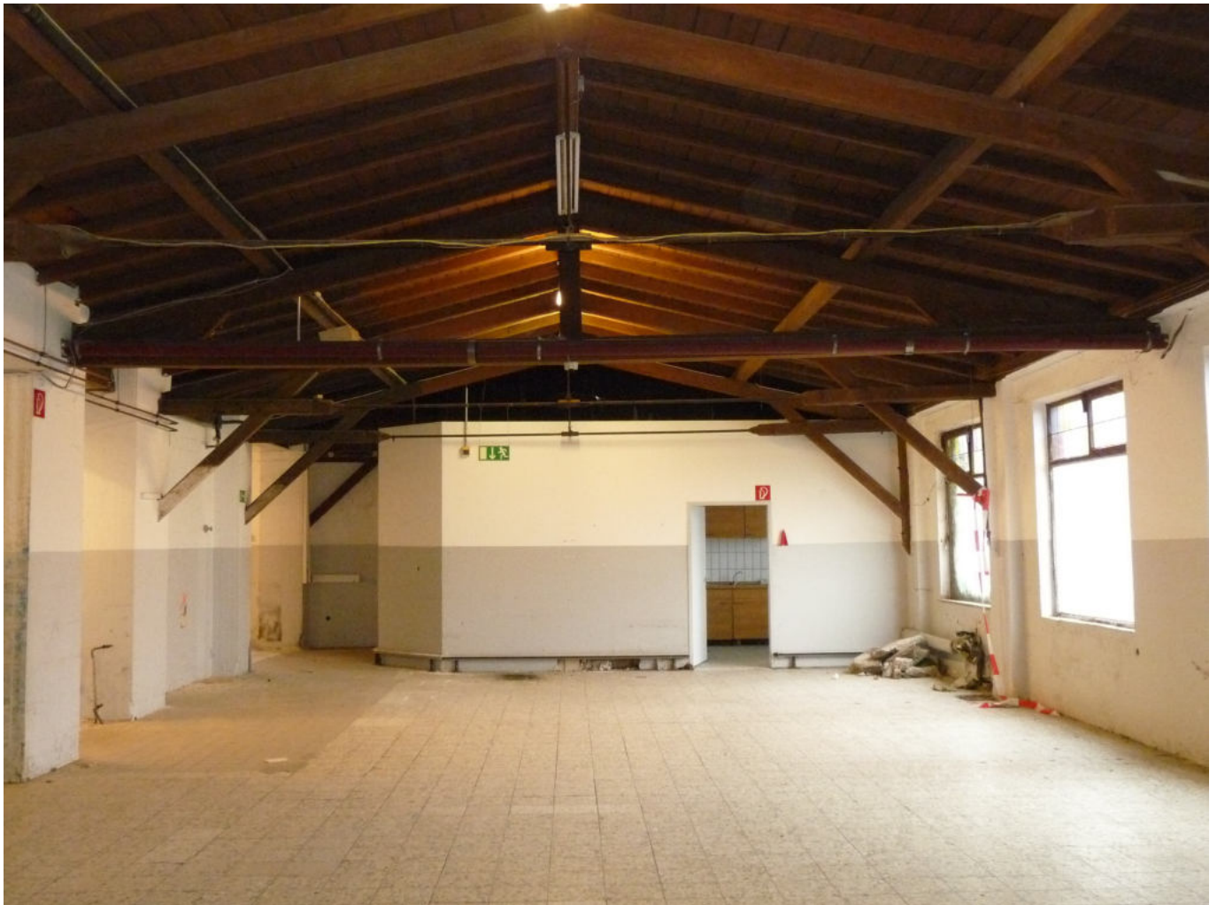
Erdgeschoss Raum 1 Industriehalle der ehemaligen Grube Langenberg, Blickrichtung Osten
