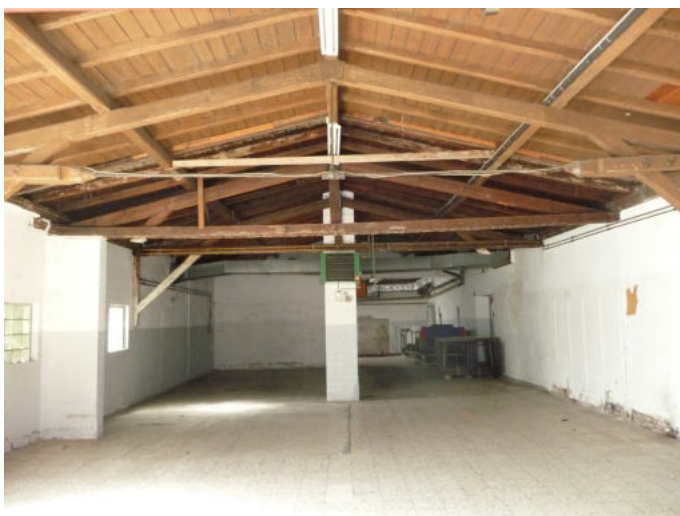
Erdgeschoss Raum 1 Industriehalle der ehemaligen Grube Langenberg, Blickrichtung Westen
