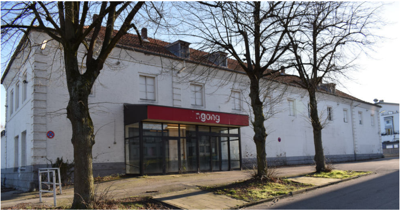
Abb. 6, Nordseite des ehemaligen Ledigenheimes der ehemaligen Grube Langenberg, März 2019
