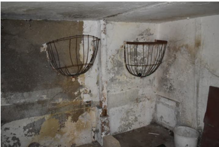
Abb. 10, Keller unter dem östlichen Anbau des Schachtgebäudes, März 2019
