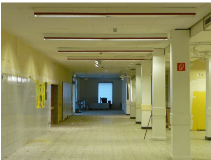
Erdgeschoss Raum 5 ehemaliges Ledigenheim der Grube Langenberg, Blickrichtung Osten
