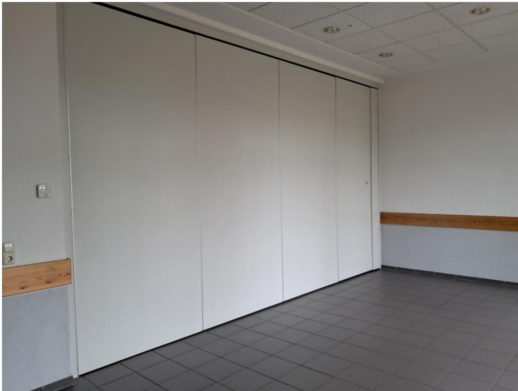
Trennwand zwischen Nebenräumen kann geöffnet werden
